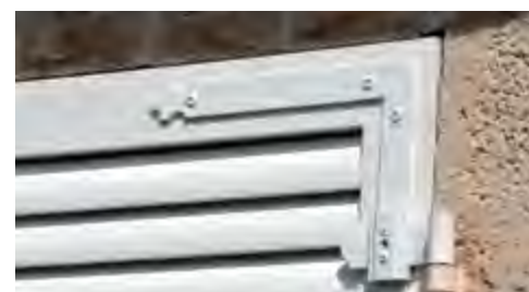
LE FERRAGE RÉNOVATION
